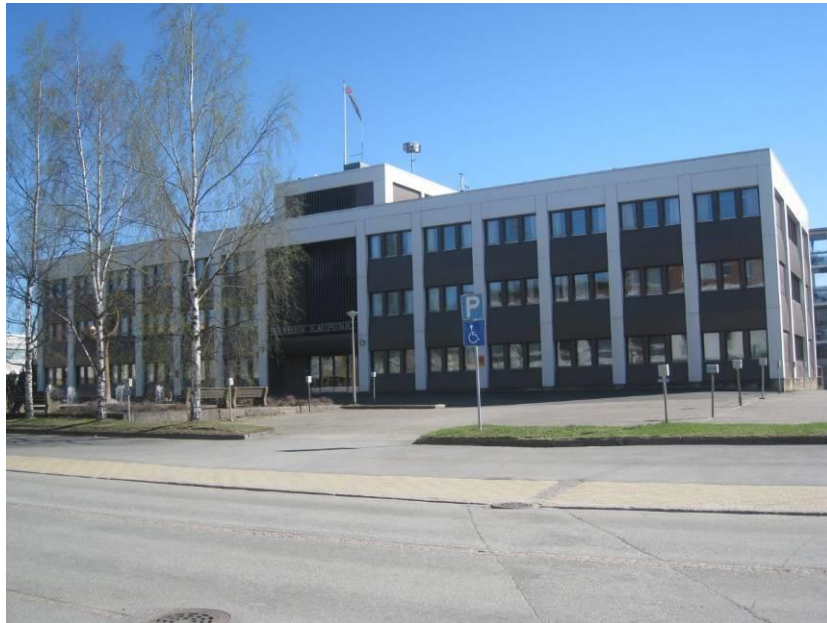
Suunnittelualueella sijaitseva rakennus, Rautatalo. Näkymä Sovionkadun puolelta
